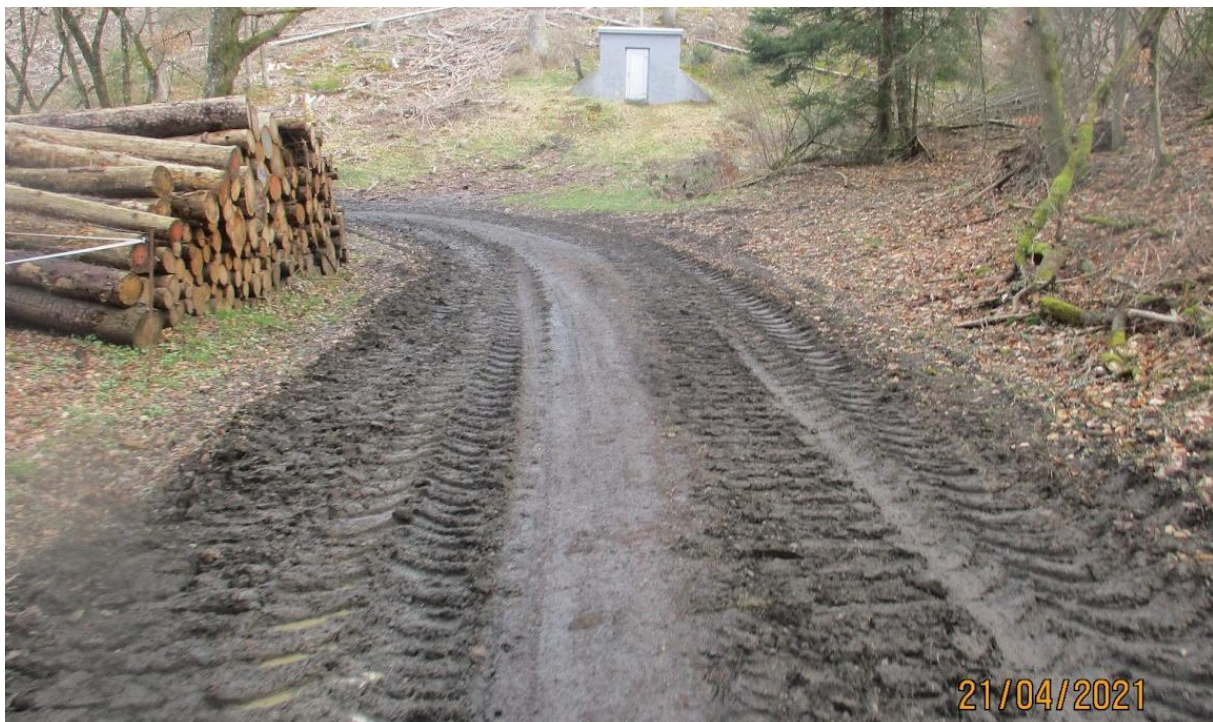
Abbildung 53: Beispiel einer Radwegeverbindung, die nach Forstarbeiten nur noch eingeschränkt nutzbar ist (eigenes Foto (VAR+, 2021))
